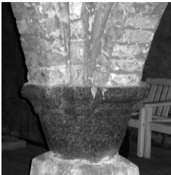
Fig. 26. Kapitäl av granit i källaren till Börjes torn. Kapitålet kan komma från en äldre, romansk byggnad.
