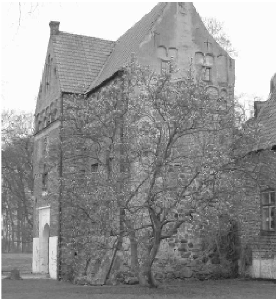
Fig. 28. Skymd av ett magnoliaträd syns porthusets framstickande parti från den andra delen av 1400-talet. Byggnaden till höger därom kan vara ett tornhus från 1300-talet. I dess hitre hörn syns en 10 meter hög förtagning till 1400-talets ringmur. Längst till höger syns "Frustugan" från 1500-talet. Bilden är tagen från ost sydost.
