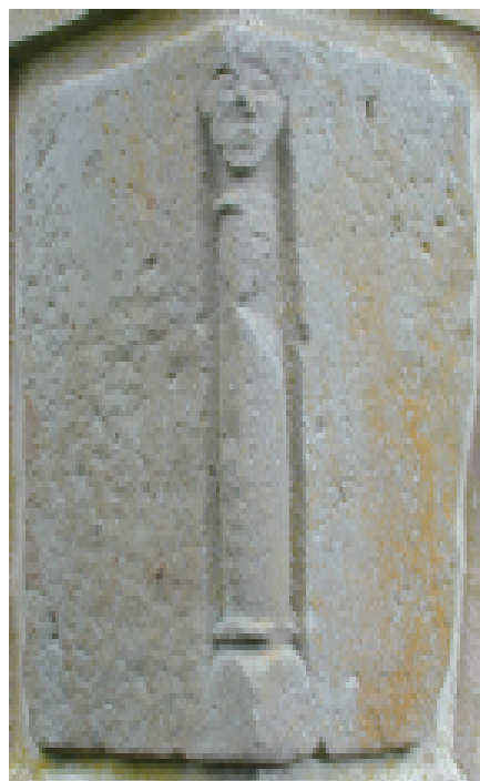
Fig. 29. Omkring 1970 murades denna sten in i det sydvästra hörnet av Börjes torn. I kvaderstenens hörn syns en huvudprydd lisen. Stenen kommer troligen från en romansk byggnad.
